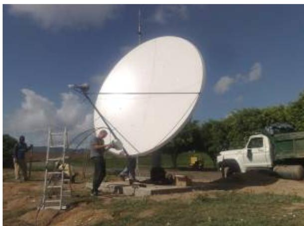
El INAC completó el 26 de Agosto la instalación de la antena y los equipos transmisores/receptores que incorporan al Aeropuerto Caracas a la red VSAT, mejorando así las comunicaciones con el resto de los aeropuertos e instalaciones INAC a nivel nacional.
