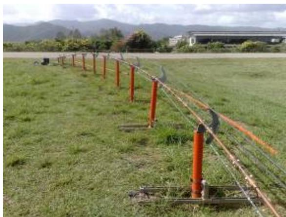
Las antenas del Glide Slope (Senda de Planeo), parte integrante del sistema ILS (Aterrizaje de Precisión por Instrumentos), fueron sometidas a un mantenimiento mayor para garantizar su buen funcionamiento. Posteriormente, el sistema ILS fue evaluado satisfactoriamente por el INAC el 6 de Agosto
