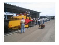
Aeropuerto Caracas, inevitablemente debemos hacer las reparaciones a medida que se van produciendo los asentamientos. Es por esta razón, que continuamente se realizan obras de mantenimiento y reparaciones menores en diferentes áreas comunes del aeropuerto.
